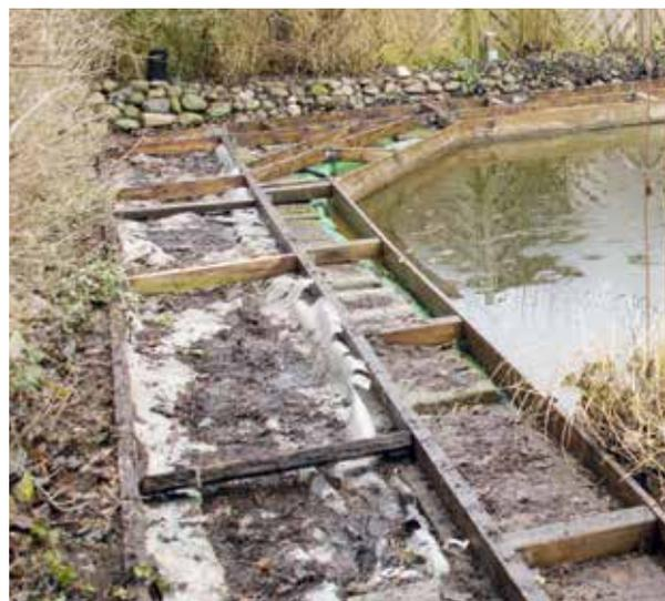
*Nach dem Abnehmen des verwitterten Holzdecks wurde das ganze Ausmaß der Verrottung sichtbar.*
